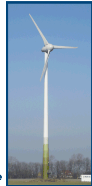
Enercon E33 Turbine
